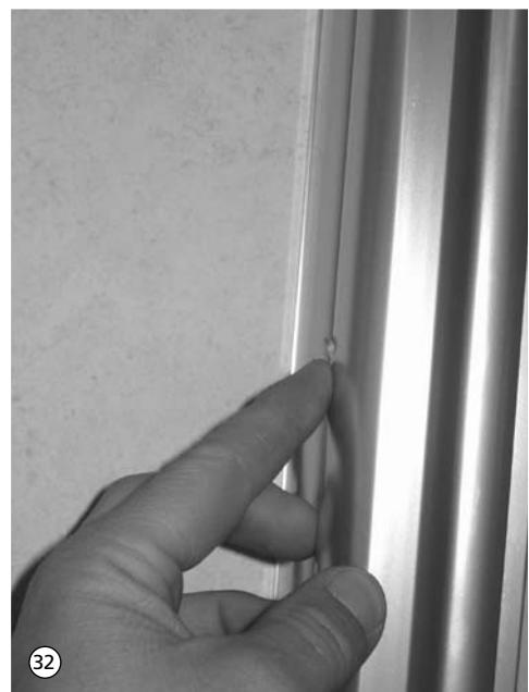
33. Spaltdichtung auf den geraden Flügel oben einige Zentimeter auf die Scheibe aufstecken, somit wird verhindert, dass die Dichtung abknickt und dadurch unbrauchbar wird.
