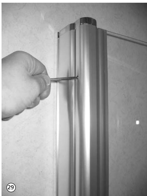
29. Türen schließen und die Flügel auf einen parallelen Verlauf zur Wanne oder Fuge hin kontrollieren. Eventuell nochmals Korrekturen an der Justierschraube oder den Gelenkeinheiten vornehmen wie unter Punkt 22 beschrieben.
