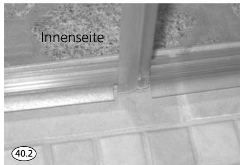
41. Versiegelung an den Gelenkeinheiten von außen ca. 150 mm senkrecht in der Höhe und waagerecht an der Gelenkplatte bis zur vorderen Öffnung. Die Öffnung komplett versiegeln.
