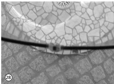
28. Gebogene Flügel so ausrichten, dass beide miteinander fluchten und die Türscheiben lotrecht zueinander stehen. Eventuell an den Glenkeinheiten die Schrägstellung korrigieren.
