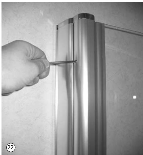
22. Geraden Flügel lotrecht ausrichten. Hierzu wird der Flügel nach innen gefaltet, die Bohrungen der Justierschrauben am Drehprofil werden sichtbar. Mit Innensechskantschlüssel SW 4 Einstellung vornehmen.
