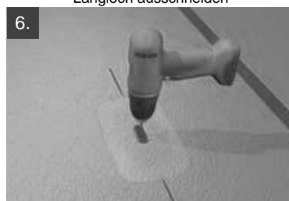
6. Mittig im Langloch vorbohren, Ø 8 mm
