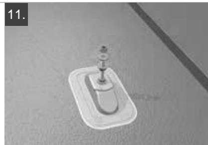
11. Scheiben und Flanschmutter anbringen.
