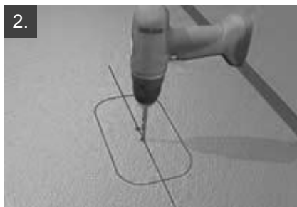
2. Langloch vorbohren
