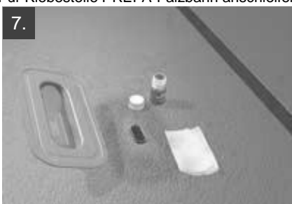
7. Angeschliffene Klebestellen mit Haftreiner reinigen
