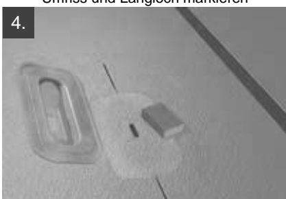
4. Für Klebestelle PREFA-Falzbahn anschleifen
