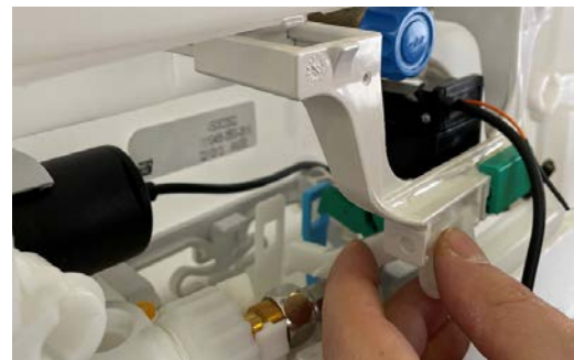
Umlenkarm mit Ersatzelektronik einsetzen. Dabei ist zu beachten, dass beide Betätigungshebel in die Vorrichtung am Ablaufventil geführt werden.
