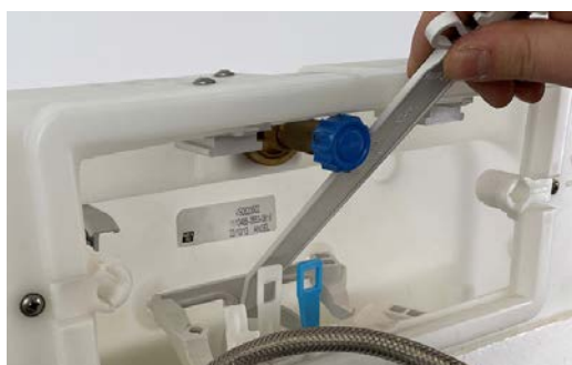
Beiliegenden Niederhalter für Ablaufventil montieren.
