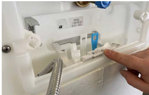
Lagerbock mit Füllventilhalter in Vorrichtung einsetzen und herunterdrücken.
