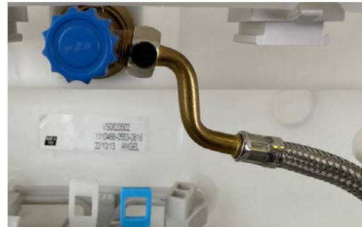
Zustand montierter Panzerschlauch.
