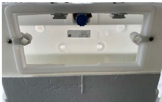
Innenleben Spülkasten Typ A12 komplett ausbauen.
