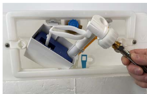
Füllventil mit montiertem Panzerschlauch in den Spülkasten legen. Zur vereinfachten Montage den Panzerschlauch zur Seite legen.
