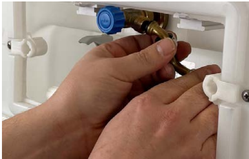
Panzerschlauch auf Eckventil stecken und festschrauben.
