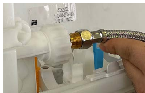
Füllventil auf Füllventilhalter montieren.
