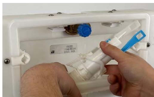
Ablaufventil einsetzen.
