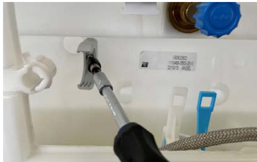
Halter Batteriemodul mit beiliegender Schraube befestigen.
