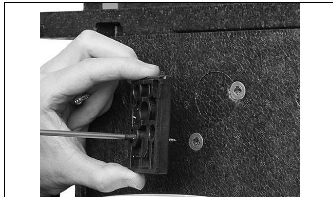
Befestigen Sie die Anzeige/das Rechenwerk des Energiezählers auf der Konsole. Die Drähte vom Fühler im Inneren der Einheit durch den Kanal/die Öffnung in der Wärmedämmplatte ziehen.
