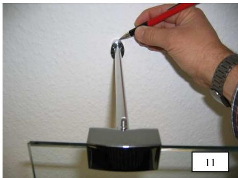
11. Die Halterohre an die Wand schwenken und die Position der Befestigungsbohrungen anzeichnen. Dabei waagerechte Ausrichtung der Halterohre beachten.
