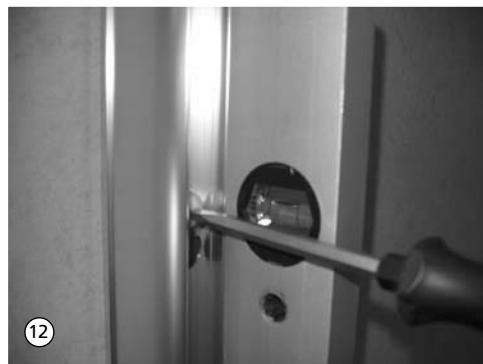
12. Gelenkprofil mit den weißen Kunststoff-schrauben lotrecht ausrichten.
