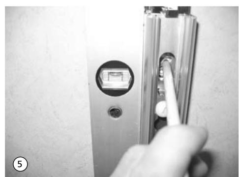
6. Schließseitiges 8 mm U-Profil positionieren und lotrecht ausrichten. Das Einrückmaß der Gelenkeinheit übernehmen und mit 15 mm addieren, (Beispiel Gelenkeinheit 8 mm + 15 mm = 23 mm).
