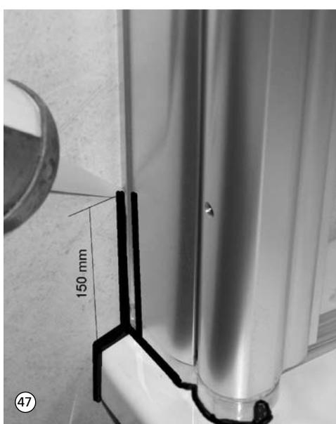
47. Versiegelung an der Gelenkeinheit von außen circa 150 mm senkrecht in der Höhe und waagerecht an der Gelenkplatte bis zur vorderen Öffnung. Die Öffnung komplett versiegeln.
