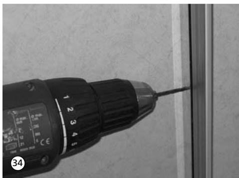
34. Schließt die Tür optimal, dann können die U-Profile (Schließseitige Profileinheit) miteinander verbohrt und verschraubt werden. Hierzu werden 3 Bohrungen Durchm. 2,3 mm gebohrt und 3 x Linsenkopfschrauben 2,9 x 9,5 mm verwendet. Vor dem Verschrauben muss je eine Rosette auf jede Schraube aufgeschoben werden.
