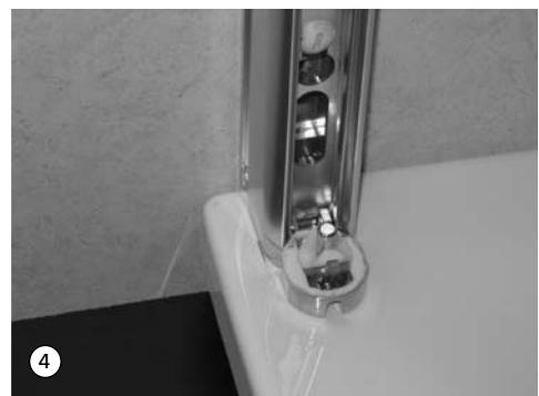
5. Lotrecht ausrichten und die Bohrlöcher anzeichnen.
