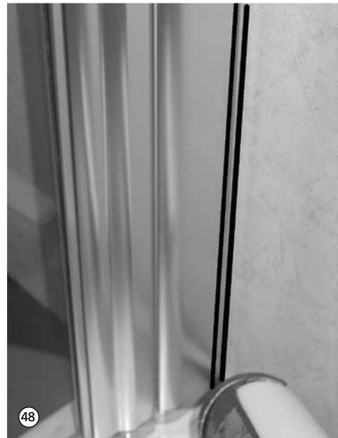
49. Versiegelung an der Schließseite von außen circa 150 mm senkrecht und an der Türmagnetdichtung entlang.
