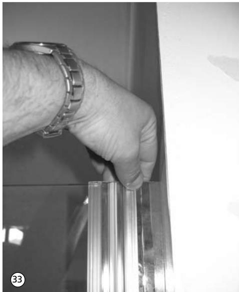
33. Tür schließen und 6 mm U-Profil so zur Tür ausrichten, dass diese leicht schließt und die Magnete sich gegenseitig anziehen (Polarität beachten). Ist der Verstellbereich an beiden Profilen nicht ausreichend, kann wie unter Punkt 23 beschrieben eine zusätzliche Verstellung an den Justierschrauben vorgenommen werden.
