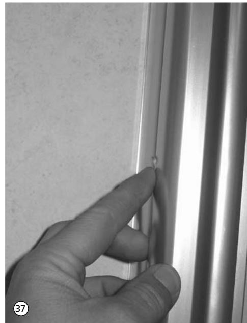
38. Spaltdichtung auf den geraden Flügel oben einige Zentimeter auf die Scheibe aufstecken, somit wird verhindert, dass die Dichtung abknickt und dadurch unbrauchbar wird.
