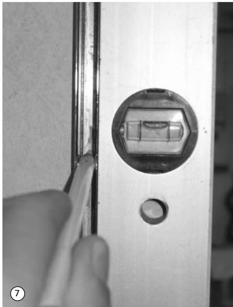
7. Bohrlöcher anzeichnen, bohren und Dübel setzen.
