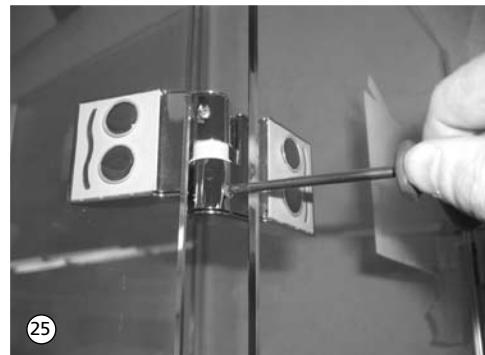
26. Beschlagabdeckungen montieren. Dabei Zuordnung Links „L“ und Rechts „R“ beachten. Vor Montage der Beschlagabdeckungen nochmals alle Befestigungsmuttern M8 mit einem Drehmoment von 15 Nm anziehen.
