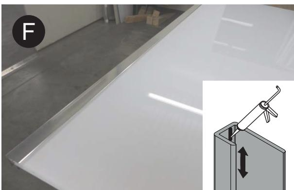
Im Abschlussprofil eine durchgehende Raupe universelle Sanitär-Dichtmasse ziehen und für 10 Minuten bis zum Anschlag in die Platte drücken.
