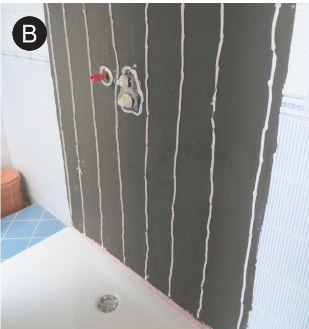
Power-Montagekleber im Abstand von 15 cm mit der V-Spitze in durchgehenden Bahnen auf die Wand auftragen. Vom Rand ist ein Abstand von 5 cm einzuhalten.
