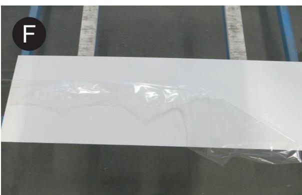
Die transparente Folie auf der Rückseite vollständig abziehen.
