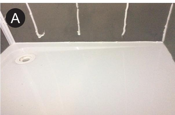
Entlang des Tassenrandes eine Raupe universelle Sanitär-Dichtmasse ziehen, damit die Platten am Boden versiegelt sind.
