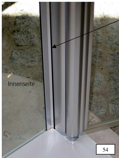
53. Versiegelung innen an der Seitenwand mit Gelenkeinheit 1x senkrecht auf der kompletten Profillänge.
