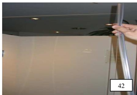
42. Türmagnetdichtungen auf die Türflügel oben einige Zentimeter aufstecken, somit wird auch hier ein abknicken verhindert. Mit der Unterkante der Türflügel bündig montieren und an der Oberkante abschneiden.
