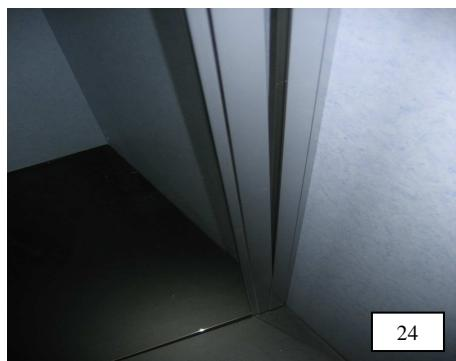
24. Seitenwand mit vormontierter zweiten Gelenkeinheit vorsichtig in das U-Profil einschieben und darauf achten, dass die Scheibenkanten beim Aufsetzen auf die Wanne oder den Boden nicht beschädigt werden. Hierzu können die im Zubehör beiliegenden 2 bzw. 3 mm dicken Verglasungsklötzte zum Schutz unter die Scheibe gelegt werden. Vorher untere Gelenkplatte auf der äußeren Hälfte ebenfalls mit Silikon versehen.
