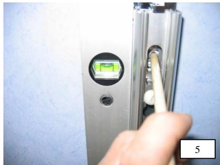
5. Beide Profile lotrecht ausrichten, Bohrungen anzeichnen, bohren und Dübel setzen.
