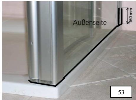
53. Versiegelung an der Seitenwand mit Gelenkeinheit von außen ca. 150 mm senkrecht in der Höhe und waagerecht an der Seitenwand bis zur Gelenkplatte und deren vordere Öffnung komplett versiegeln (siehe Schritt 52). Innen wird 2x senkrecht auf der kompletten Profillänge.
