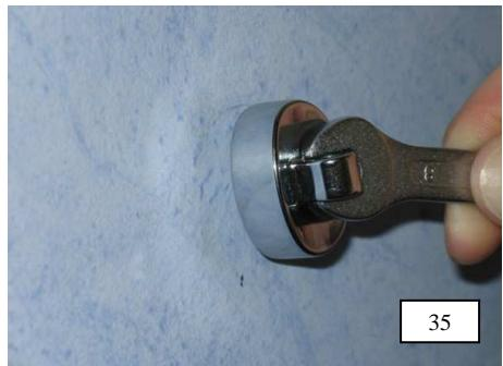
35. Alternativ Stockschraube M6 x 60 zunächst in die Gelenkplatte eindrehen. Danach vormontierte Gelenkplatte mit Maulschlüssel SW 8 in Dübel eindrehen.
