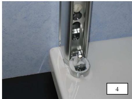
4. Gelenkeinheit und U- Profil an die Markierung setzen.
