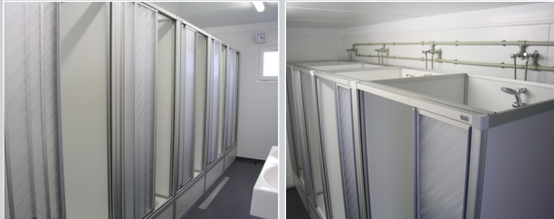
■ Roth Komplett dusche Exklusiv: Einbau in Wohn-/Nutzcontainern (hier Sanitärcontainer für Feuerwehr)
