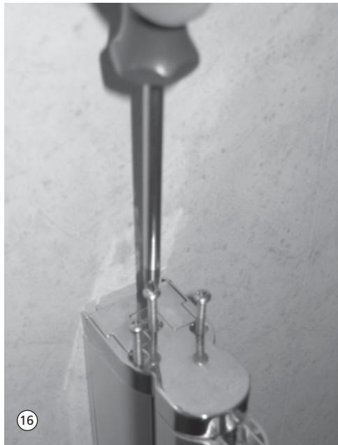
16. Mit 3 Linsenkopfschrauben 3,5 x 32 mm befestigen.
