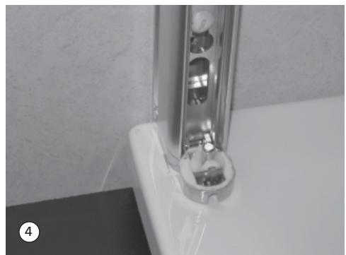
5. Lotrecht ausrichten und die 4 Bohrlöcher anzeichnen, bohren und Dübel einsetzen.
