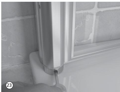
23. Bei Bedarf kann der Türflügel abgesenkt werden, Innensechskantschlüssel SW 3 verwenden. Auslieferungszustand ist oberste Stellung. Anheben ist nur möglich, wenn der Flügel demontiert ist.
