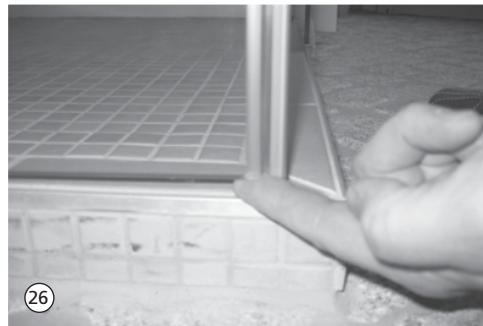
27. Türen schließen und die Flügel auf einen parallelen Verlauf zur Wanne oder Fuge hin kontrollieren. Eventuell Korrekturen mit den Justierschrauben vornehmen wie unter Punkt 19 beschrieben.
