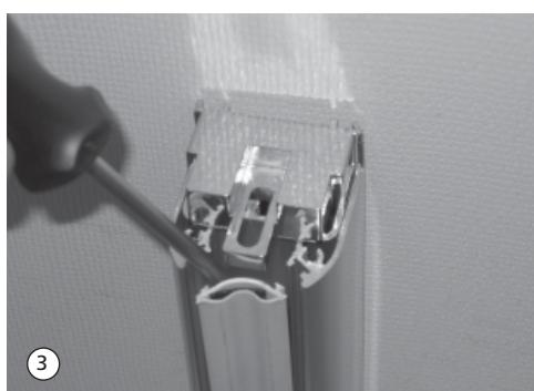
3. Obere Gelenkplatte und Gelenkdichtung demontieren.
