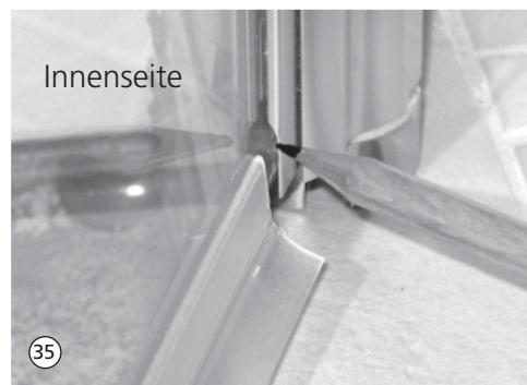
36. Pfeil zeigt die endgültige Position der Dichtung an der unteren Gelenkplatte.
