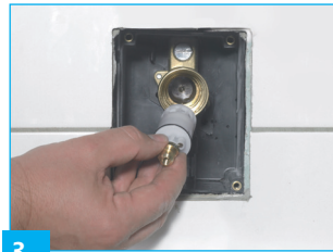
3. Weißen Blindstopfen entfernen. Kartusche einsetzen.
