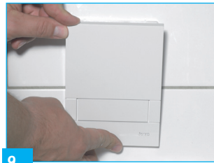
9. Frontplatte (Kunststoff- oder Glas-Variante) auf Kunststoff- Halterahmen aufsetzen und in Schnappverbindung einrasten. Die EXCLUSIVE-Urinalsteuerung (manuell) ist nun betriebsbereit.
