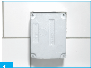
1. Bauschutz von UP-Box entfernen.
