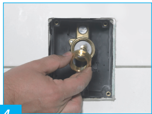
4. Überwurfmutter aufschrauben und anziehen!
