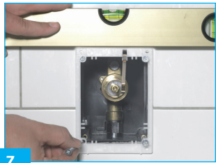
7. Exakt ausrichten und Kunststoff- Halterahmen auf Wandeinbau- kasten aufschrauben. Vorabsper- rung öffnen!
